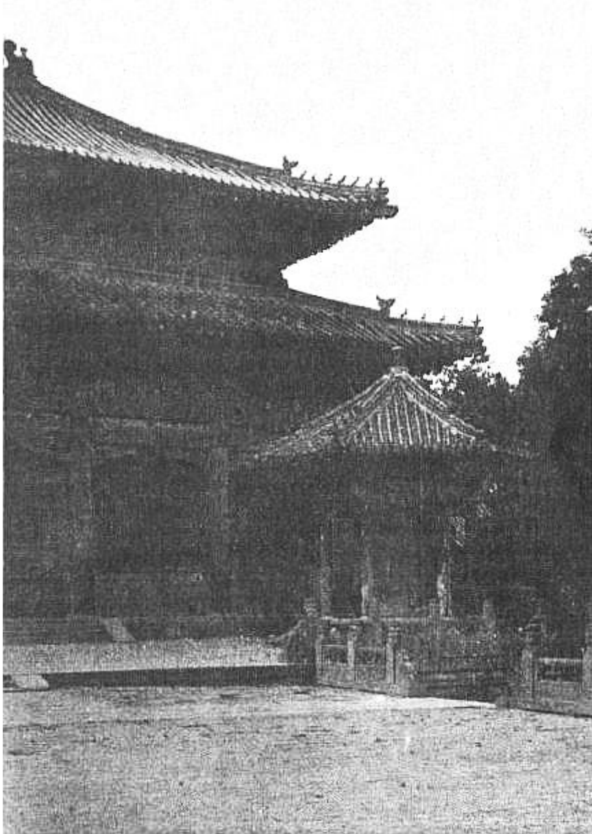
39. Pavillon à l'angle oriental de la façade du Siun ki tien.
